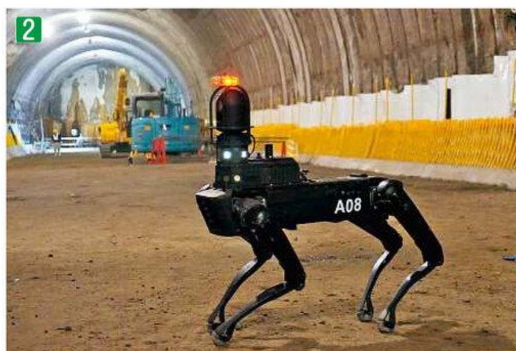
トンネル内を見まわり
